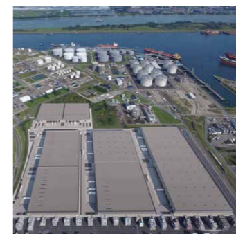
SMARTLOG ROTTERDAM 2 WOLGAWEG BOUWJAAR: 2017 AANTAL M 2 : 97.801 M 2
